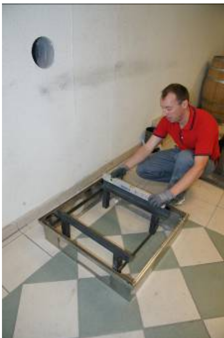
Ausrichtung des Rahmens und des Traggestells mittig der Schornsteinbohrung
