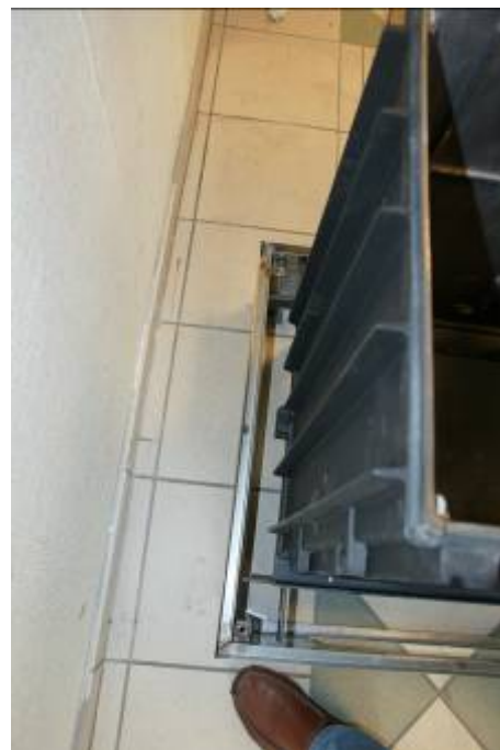
Ausrichtung des Rahmens und des Traggestells mittig der Schornsteinbohrung
