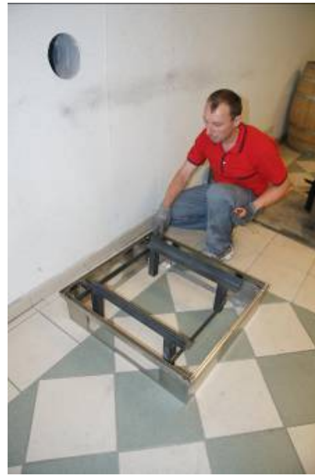
Ausrichtung des Rahmens und des Traggestells mittig der Schornsteinbohrung
