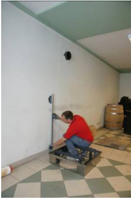
Ausrichtung des Rahmens und des Traggestells mittig der Schornsteinbohrung
